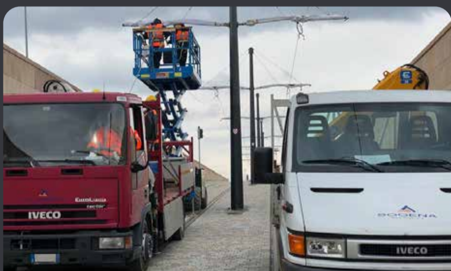
Costruzione di linea tramviaria Firenze
