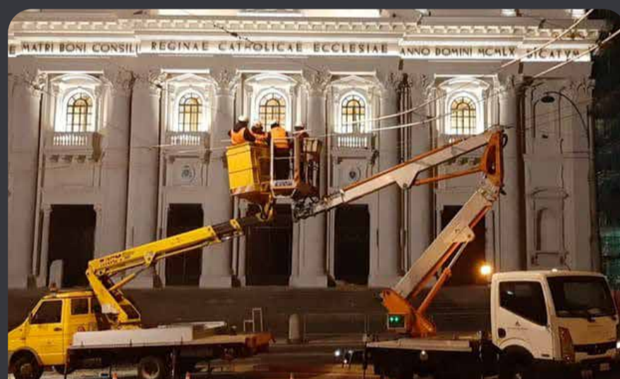
Installazione linea Filoviaria - R4 Napoli
