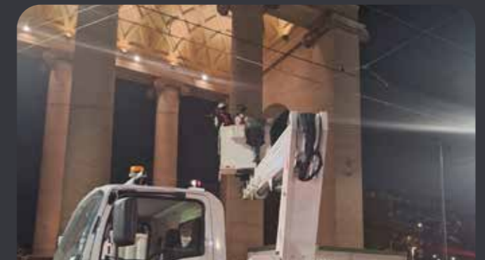
Rifacimento tratte Filotram Milano
