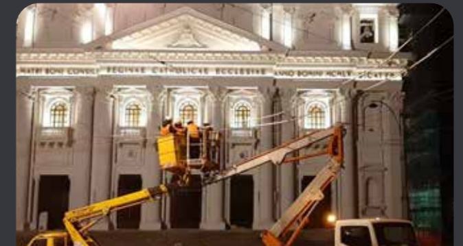
Installazione linea Filoviaria - R4 Napoli
