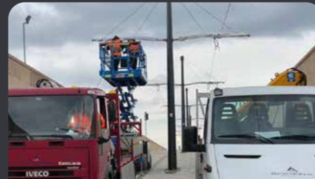
Costruzione di linea tramviaria Firenze
